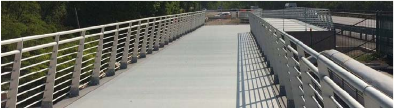
Figura 03.08.b: Esempio realizzativo di parapetto in progetto
