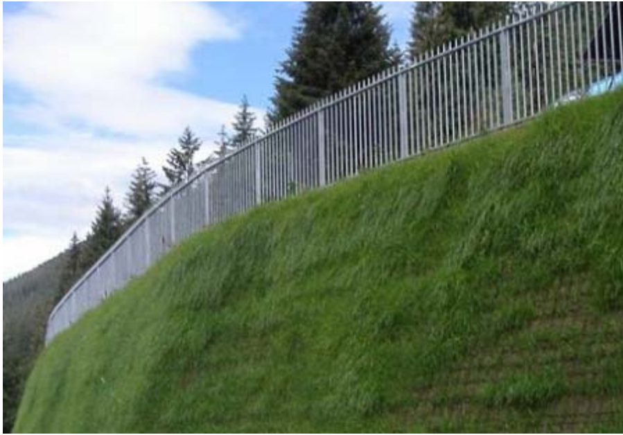
Figura 03.e: Esempio realizzativo di terra rinforzata
